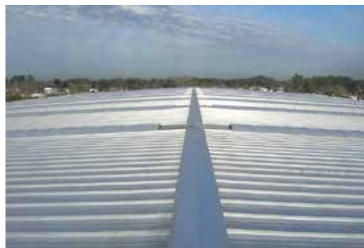
Cubierta talleres Götttert | Buenos Aires | Sistema Danpavault
