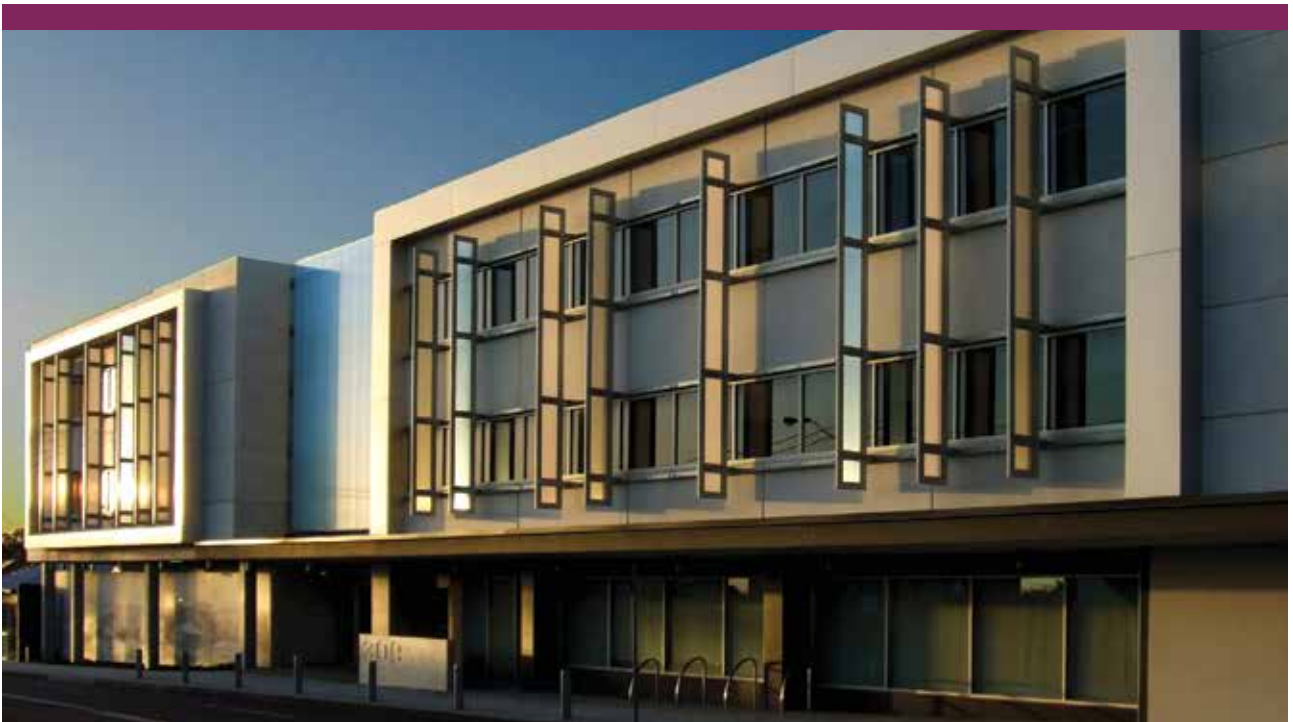
Oficinas de Servicios Comunitarios, Charlestown Australia | Sistema de cortasoles de Danpal® | Arquitectos: Jackson Teece
